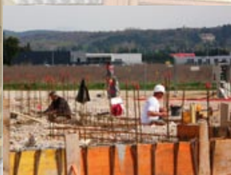
Construction de la crèche au sud du territoire 1 038 700 €
