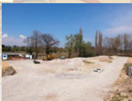
Construction de la déchèterie de Montboucher-sur-Jabron 536 402 €
